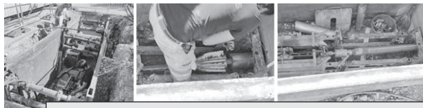
Fotos: Sanierung der Trinkwasserhauptleitung in der Kirchengasse im Berstverfahren
