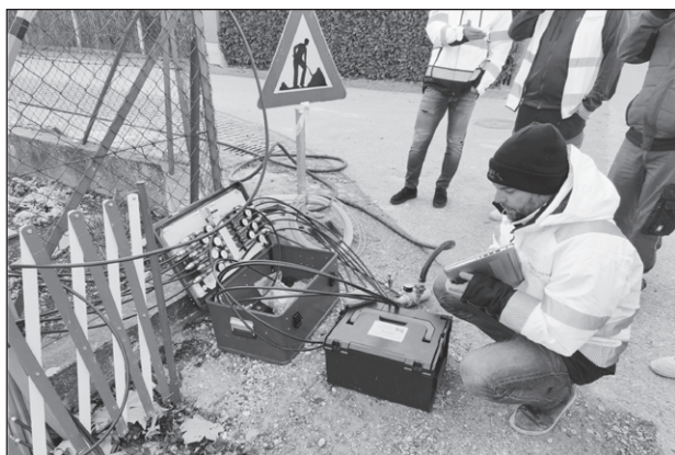
Foto: Druckprüfung (Kalibrierung) der Rohrverbände
